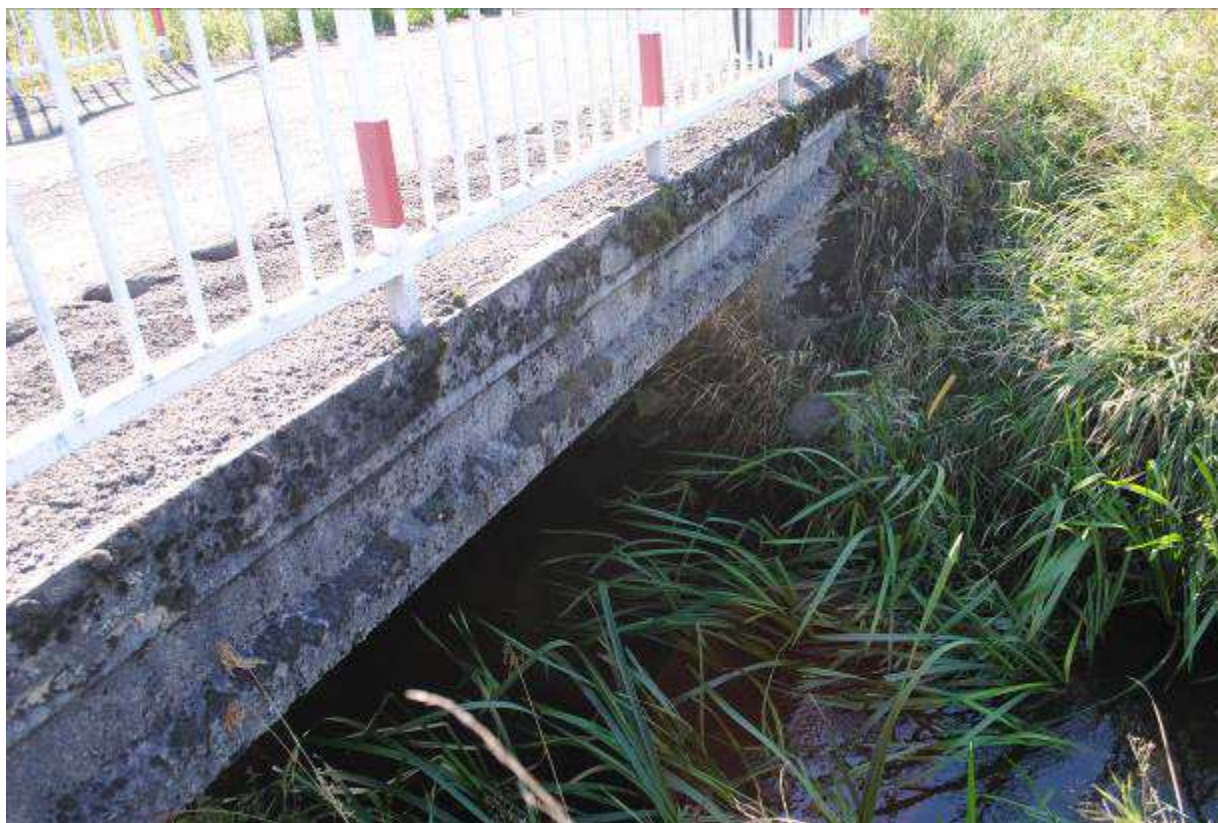
FOT 3. – widok z boku ( kapa, skrajna belka, bariera stalowa)
