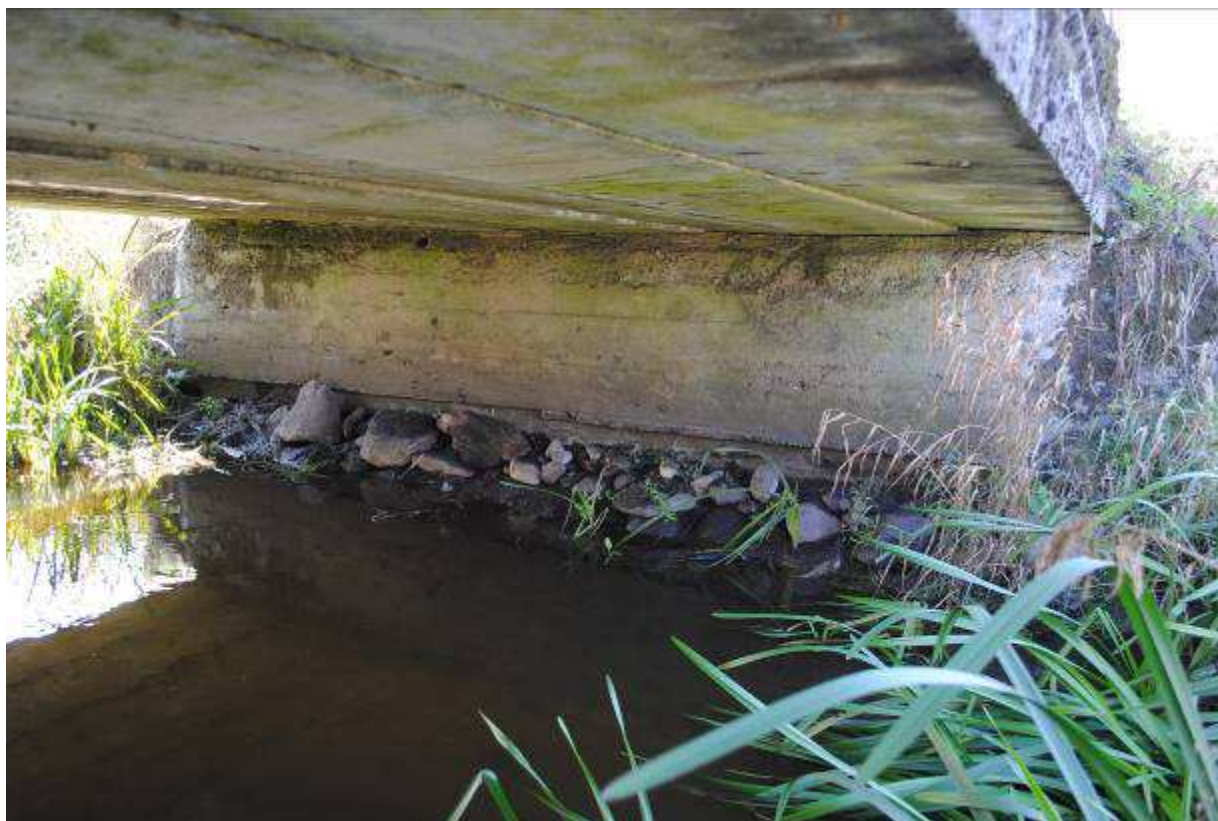
FOT 2. – widok światła mostu ( konstrukcja belkowa, przyczółek)
